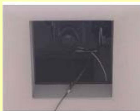
撮影スタジオ(天井開口部分)
